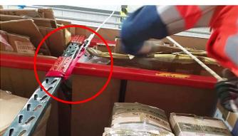
Retirer le lest HPAY081, puis relier le cordage en point bas avec un anneau d'ancrage temporaire autour d'une structure environnante d'une résistance à la charge d'au moins 10 kN. Tendre le brun de cordage opposé à l'ancrage.
